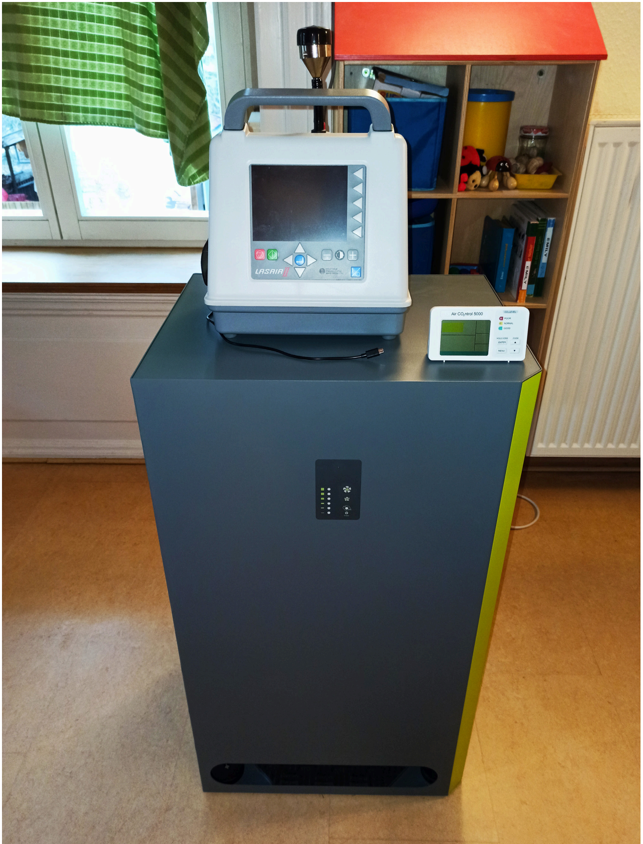
Abbildung 8: Kindertagesstätte Kindervilla | Raum Landgrafenblick | Raumluftreiniger mit HEPA 14-Filter, Volumenstrom ca. 650 m 3 /h
