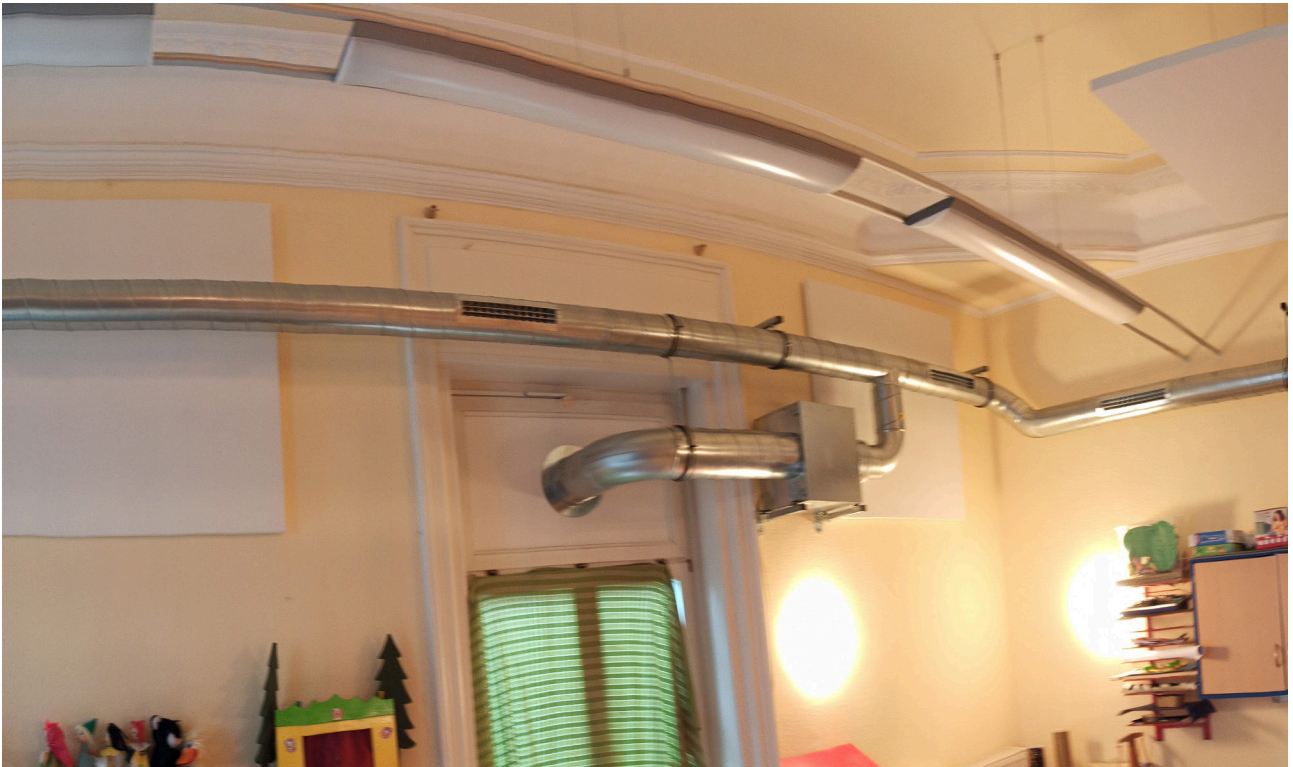
Abbildung 2: Kindertagesstätte Kindervilla | Raum Landgrafenblick | Provisorium nach dem Modell Max-Planck-Lüftungsanlage
