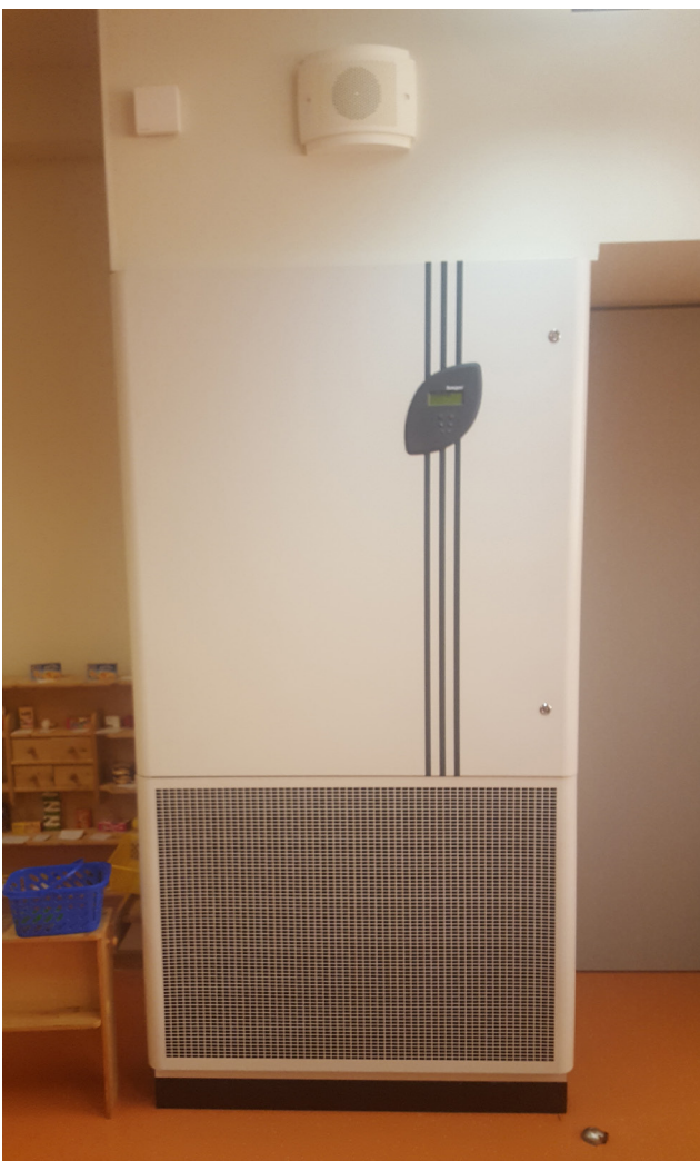
Abbildung 3: Schillerschule | Raum 03_04 | Klassenraumgerät mit Wärmerückgewinnung-Kühl- und Heizfunktion
