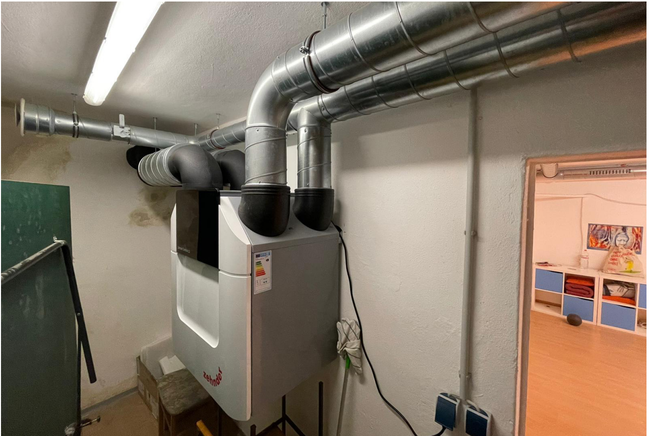
Abbildung 4: Kinderheim Friedensberg | Raum: Sportheim | Kontrollierte Wohnraumlüftung (KWL-Gerät) mit 300 m 3 /h Volumenstrom
