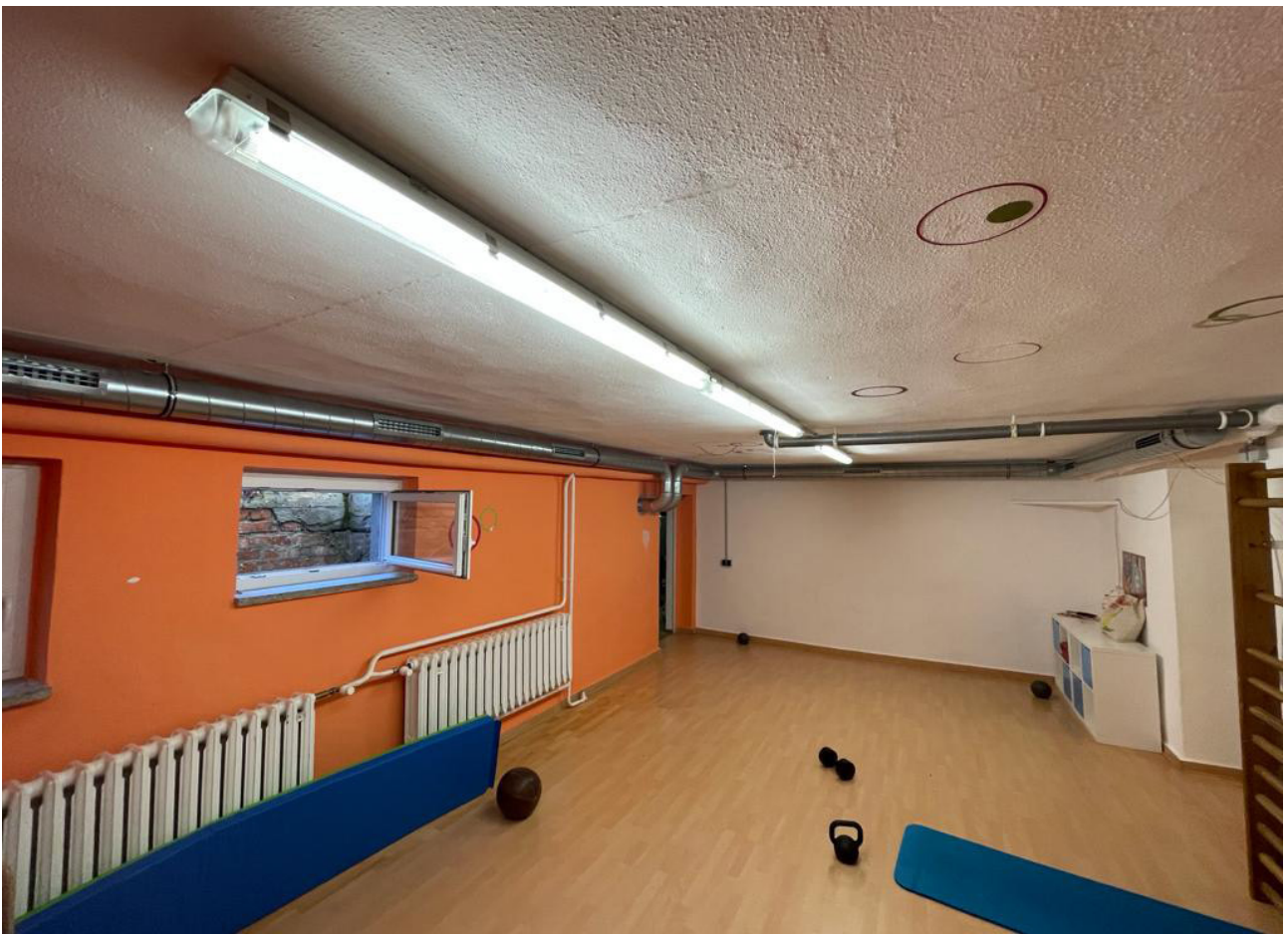
Abbildung 5: Kinderheim Friedensberg | Raum: Sportheim | Rohrleitung des Geräts zur Kontrollierten Wohnraumlüftung (KWL)
