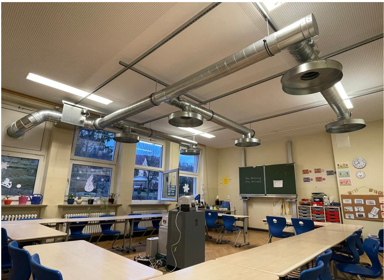
Abbildung 1: Südschule | Raum 00_18 | Provisorium nach dem Modell Max-Planck-Lüftungsanlage
