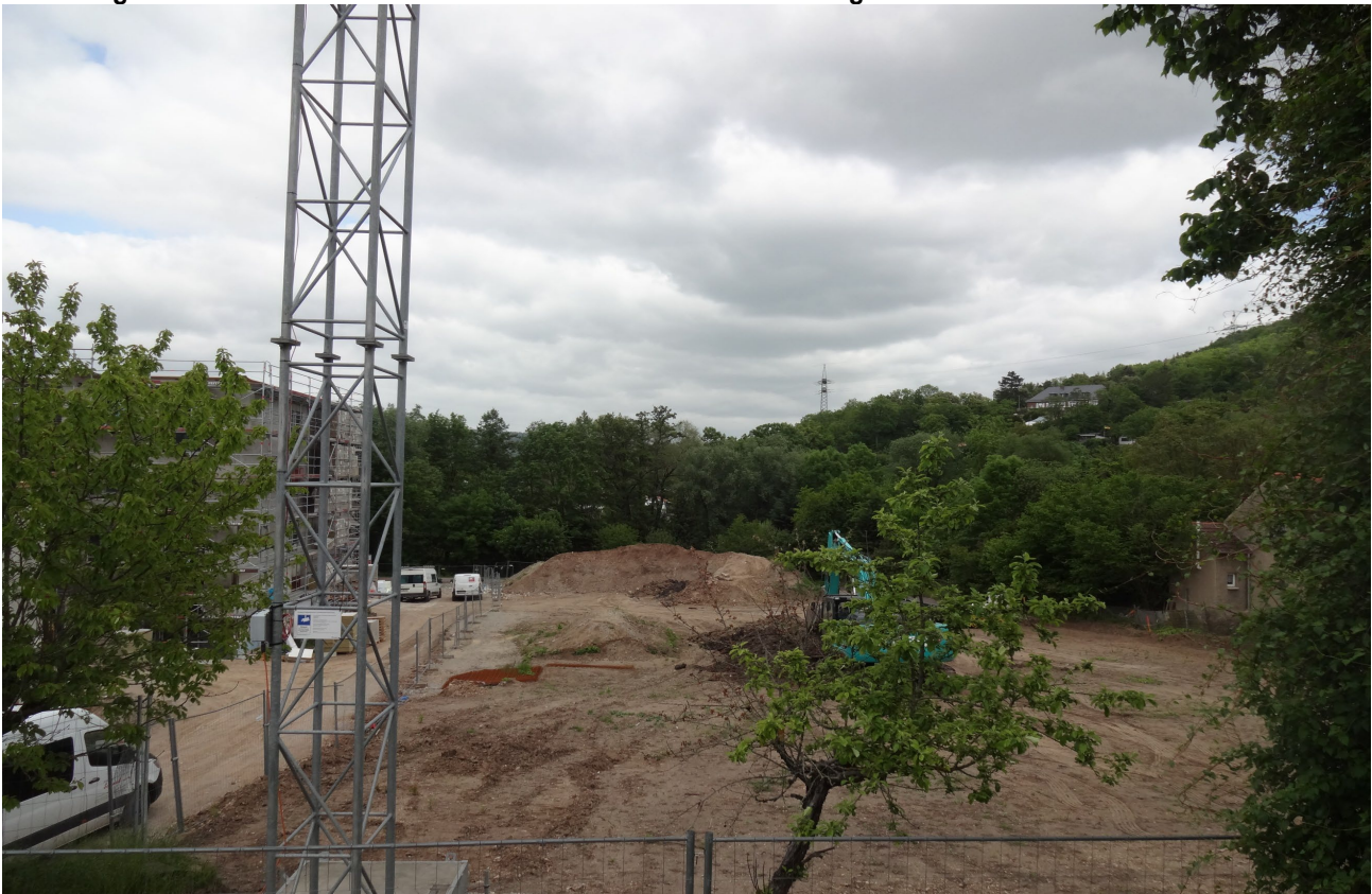
Abbildung 3: Blick von der Karl-Liebknecht-Straße über das Vorhabengebiet zum Gembdenbach
