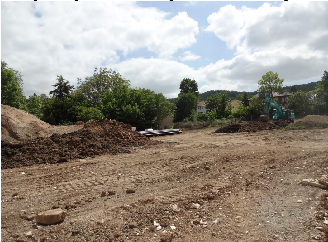
Abbildung 2: Nutzung der Fläche des Vorhabensgebiets als Baustelleneinrichtung
