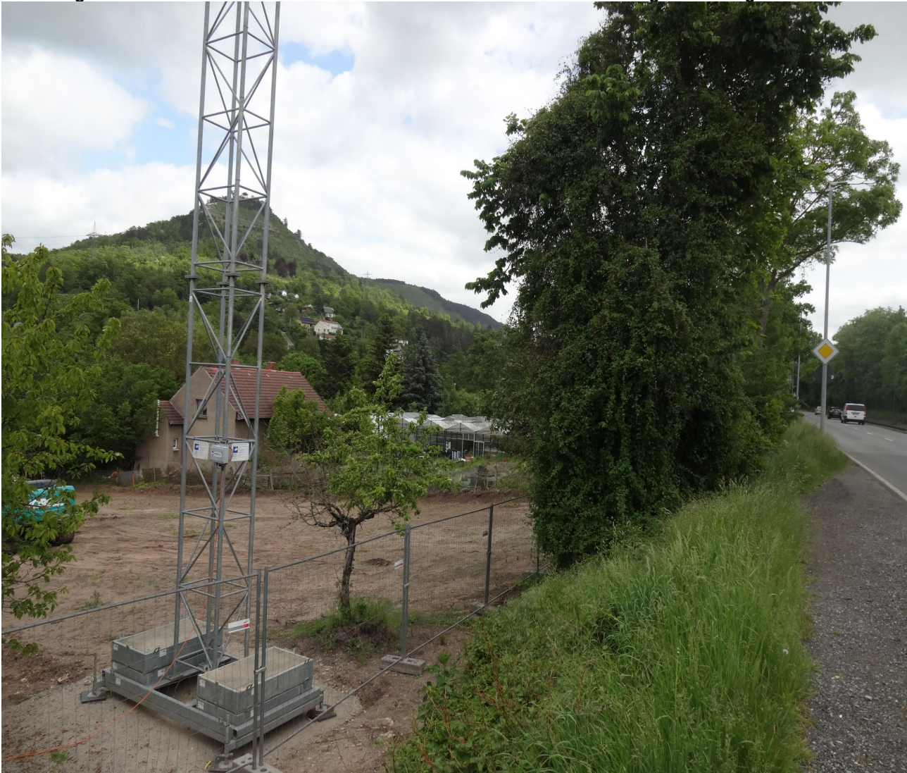
Abbildung 5: Blick von der Karl-Liebknecht-Straße über die Baustelleneinrichtung zum Jenzig
