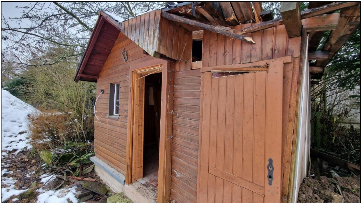
Abbildung 7: Gebäude am nordwestlichen Randbereich mit zugänglichem Dachboden
