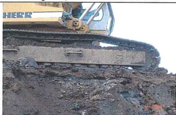
Anschnitt Deckschicht (ca. 10 cm) u. Alllastkörper
