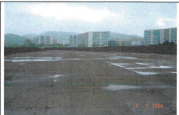
TF A nach Entfernung des Mutterbodens
