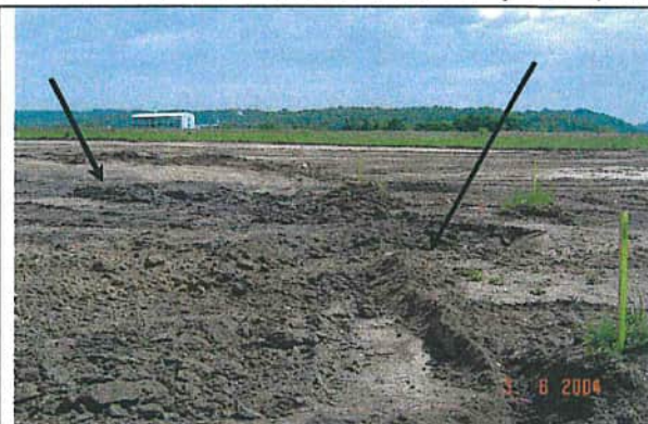
Nordgrenze Aushub nahe OKBA 4 | OKBA 1, 32, 31: Altlastkörper steht bereits an der Oberfläche an
