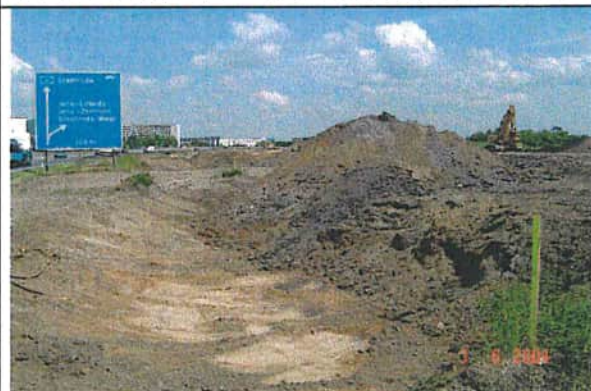
Nordgrenze Aushub nahe OKBA 4 | OKBA 1, 32, 31: Altlastkörper steht bereits an der Oberfläche an
