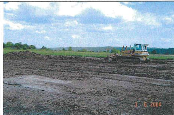
Abziehen der Deckschicht nach Osten hin
