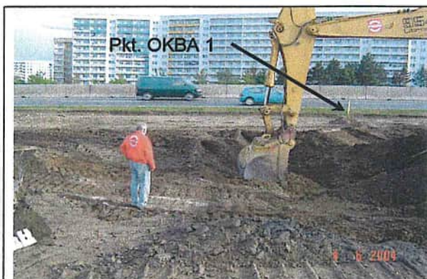
Alllast ca. 12-15 m westlicher als OKBA 1 u. 32
