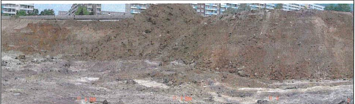
17.06.04: Seitenstoß Nord-Ost nach vorläufigem Abschluss der Maßnahmen in TF A
