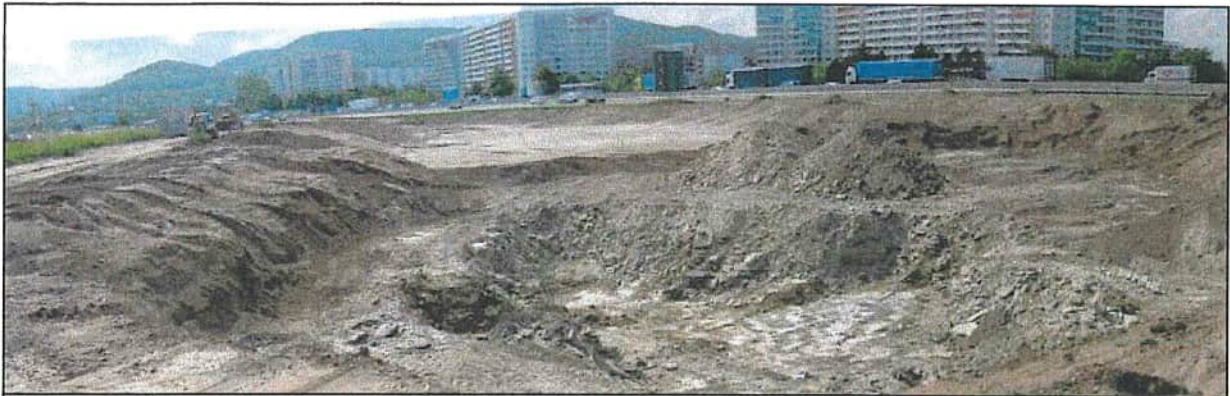
Endzustand' am 28.06.04 nach zusätzlichem Aushub im Südosten TF A (Standpunkt nahe OKBA 22)
