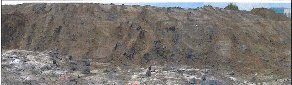
17.06.04: Seitenstoß Süd-Ost nach vorläufigem Abschluss der Maßnahmen in TF A
