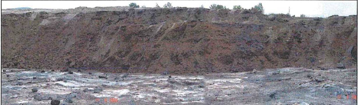
17.06.04: Seitenstoß Ost nach vorläufigem Abschluss der Maßnahmen in TF A
