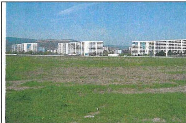
TF A vor Beginn der Maßnahme
