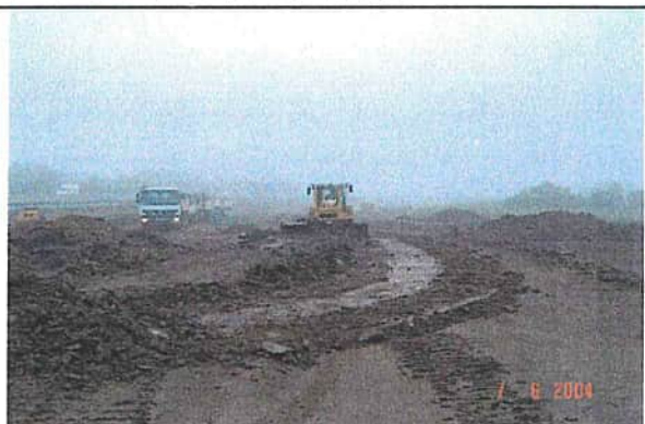
Abschieben d. nassen Deckschicht nach Regen
