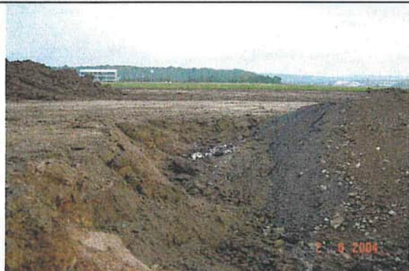
Beginn Abtrag der Abdeckschicht
