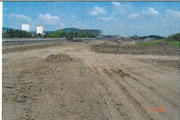
Östliche Einfahrt zur Baustelle
