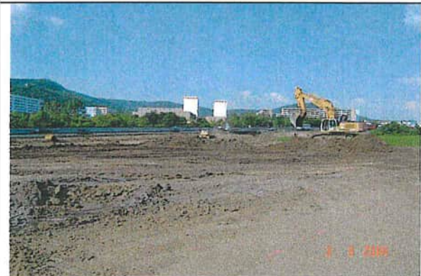
Deckschicht abgezogen und im Osten aufgehaldet
