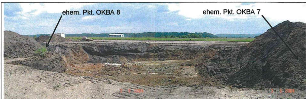
Ansicht v. Norden: Aushub erstreckt sich zw. OKBA 7 + 8 um ca. 4 m weiter nach Norden (Tiefe 1,5 m)
