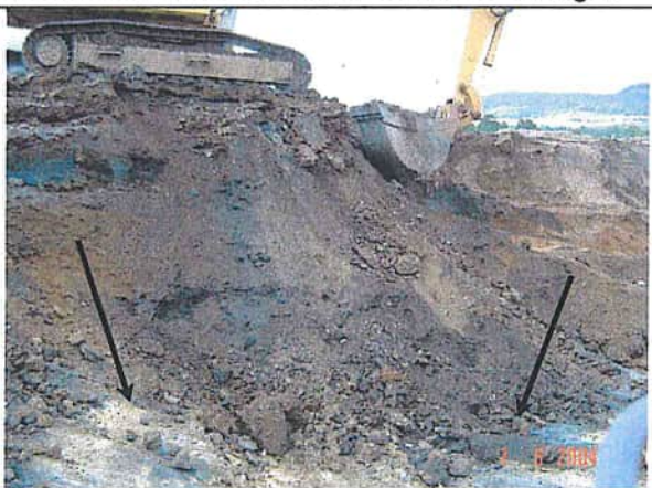
Aushub Alllast bis auf gewachsenen Sandstein
