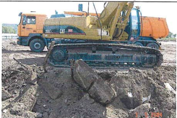
Betonteile im Westen der Baugrube
