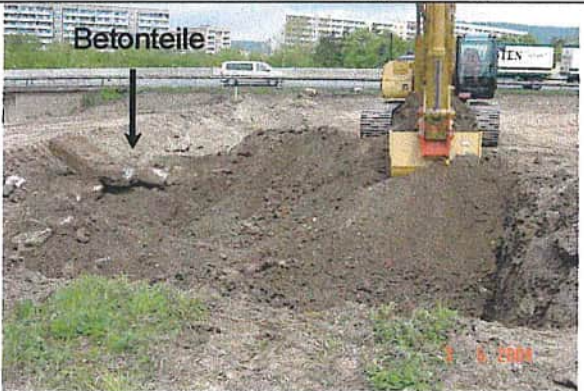
Aushub der Deckschicht nahe OKB 1
