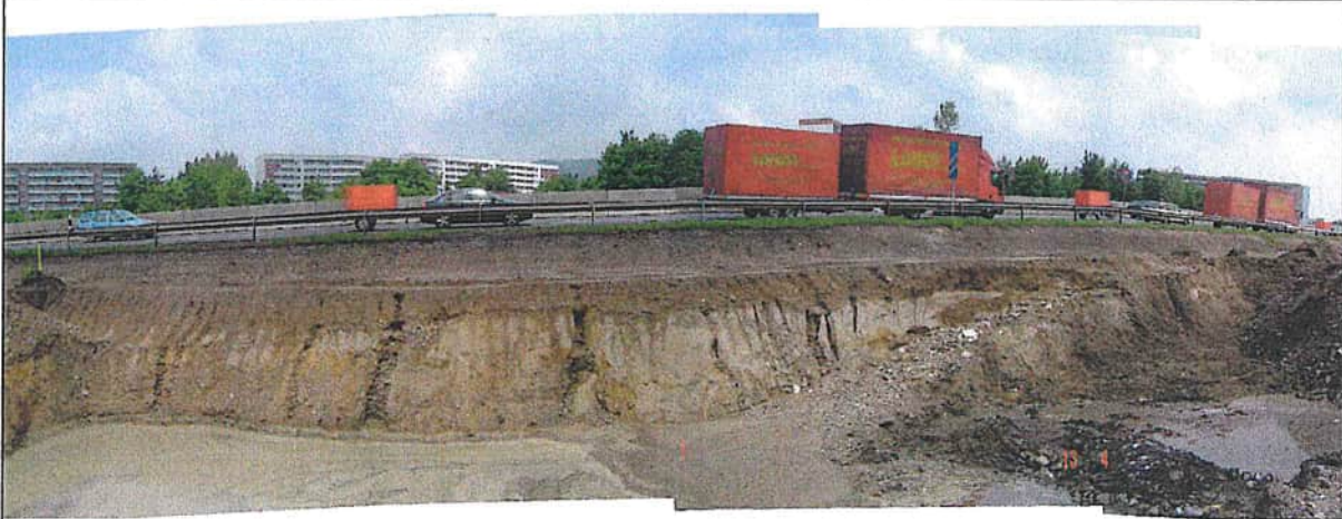
Ansicht Nordböschung Baugrube, links vorne Regenwasseransammlung, rechts Aushub Altlast
