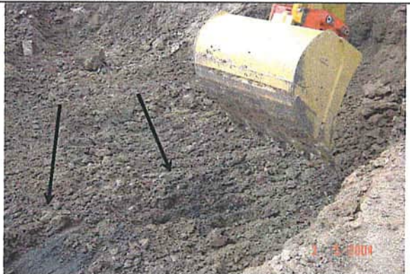
Ankratzen der Altlast in ca. 2 m Tiefe
