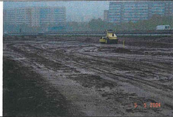
Regen verhindert Baufortschritt ab dem 05.05.04
