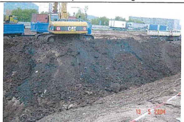
Aushubfortschritt entlang Südgrenze Baugrube
