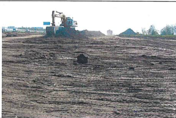
Zustand nach dem Mutterbodenabtrag
