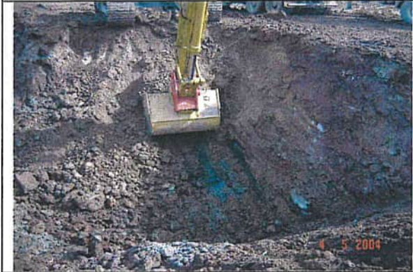
Stärke der Abdeckung nimmt nach Osten hin ab, links ca. 2 m, rechts ca. 0,20 m
