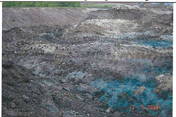
Blick nach Westen über bisherigen Aushub
