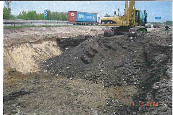
Weiterer Aushub der Altlast am 11.05.04
