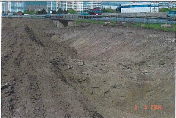
Abgetragene Deckschicht entlang Autobahn
