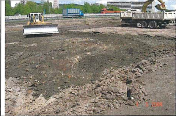
Abschieben der letzten dünnen Abdeckschichtbereiche im Osten der TF B-Nord
