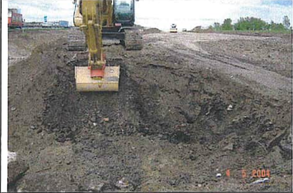
Beginn Altlastentnahme im Westen bei OKBA 18
