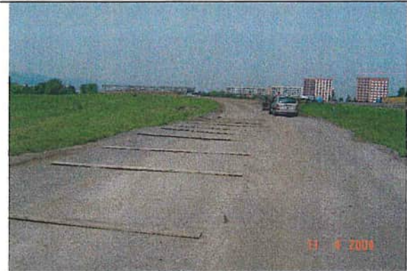
Rüttelstrecke für Verhind. Straßenverschmutzung
