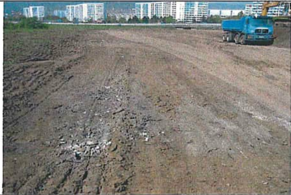
Laden und Abtransport des Mutterbodens
