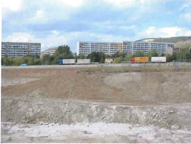
Rampen, Blickrichtung Nord
