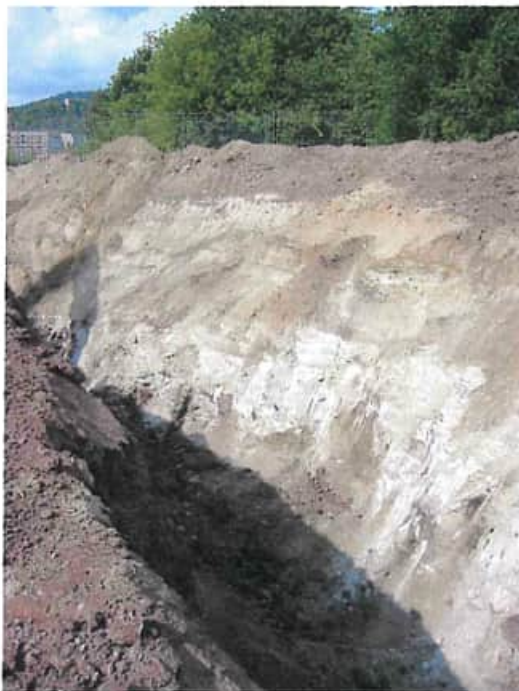
Abgrenzung zum Anstehenden der Ostböschung (OKB 8 - OKB 9) 19.07.2004
