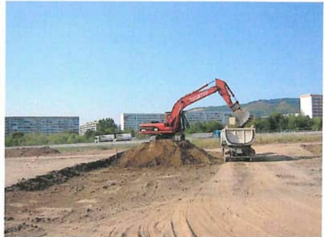
Abtrag der Abdeckschicht, Blickrichtung Nord (Neulobeda)
