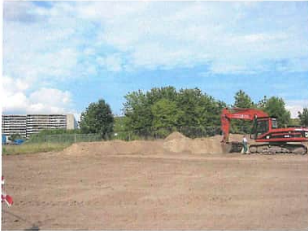
Aushubbeginn 19.07.2004, links Wohngebiet Neulobeda
