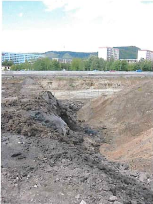
Durchbruch im Bereich OKB 11 + 12, 20.08.2004, Blickrichtung Nord (Neulobeda)
