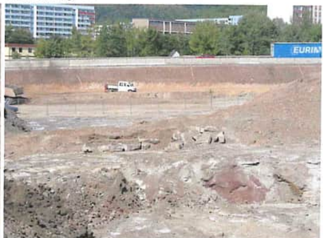
Betonteile 31.08.2004, Blickrichtung Nord
