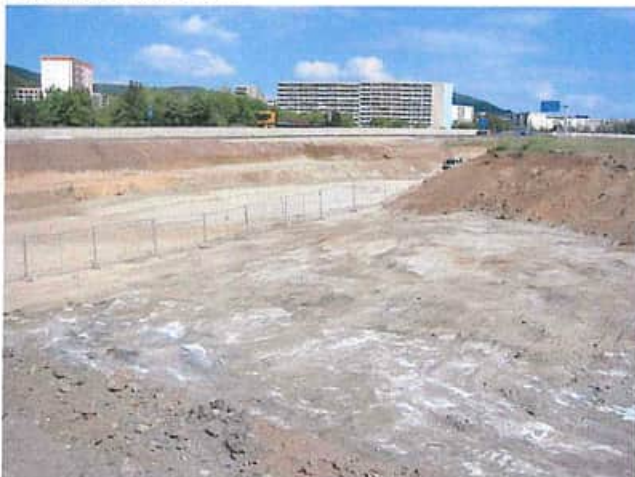
Abbaufortschritt 01.09.2004, Blickrichtung Nordost
