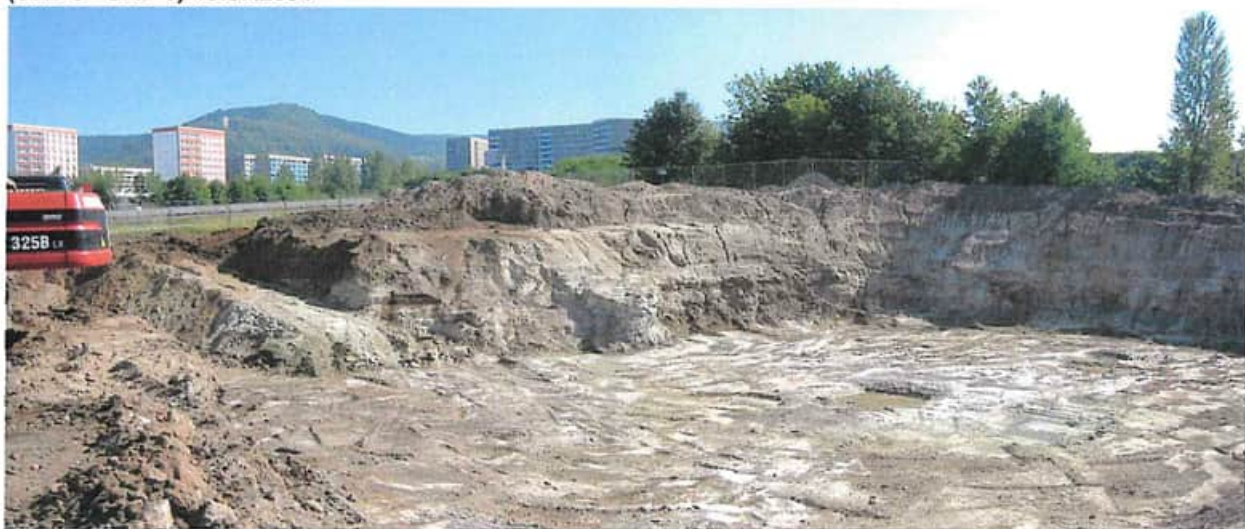
Freigelegter Aushubbereich bis OKB 10, 29.07.2004, Blickrichtung Nordost, links Wohngebiet Neulobeda
